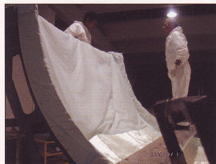
Układanie tkaniny delaminażowej
