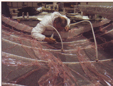
Sprawdzanie szczelności worka
